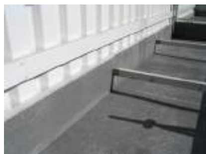
Rivestimento in resina nelle vaschette o all'interno
